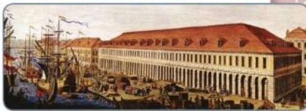
Здания Биржи и портового Гостиного двора на набережной Невы. 1753 г. Художники И. П. Еляков, М. И. Махаев, И. Э. Гриммель
